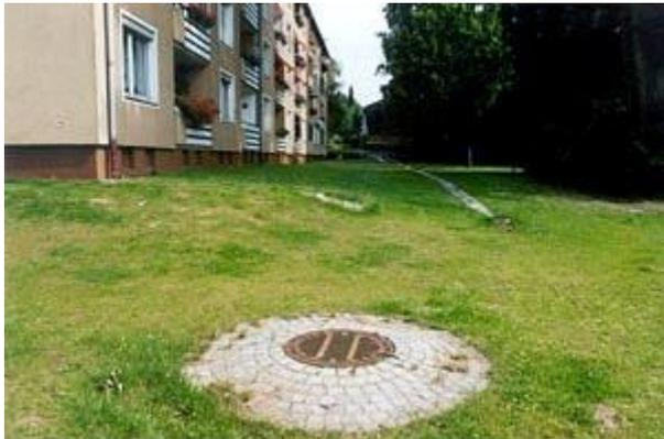
Schachtversickerung an einem Wohngebäude - die Oberfläche bleibt unberührt <http://emscher-regen.de/>
